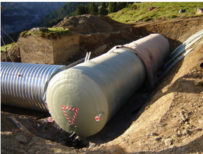
Reservoir vor dem Eindecken
