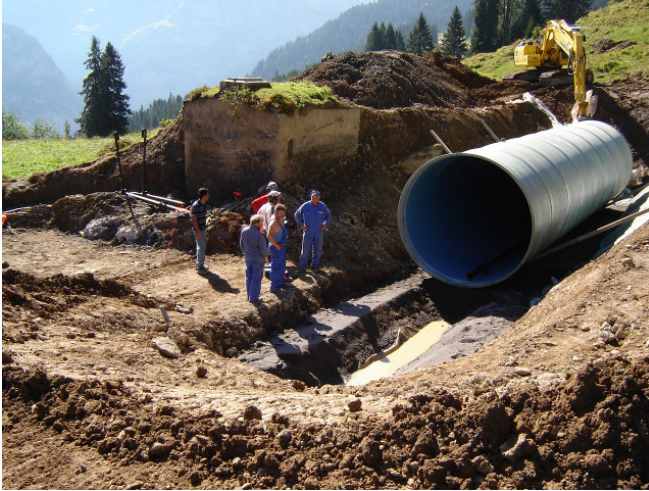
Der erste Teil des vorfabrizierten Behälters
