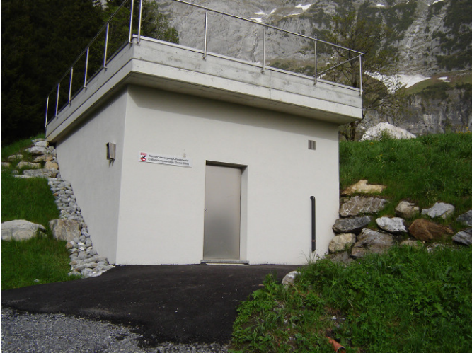
Neues Entkeimungsgebäude nach der Fertigstellung
