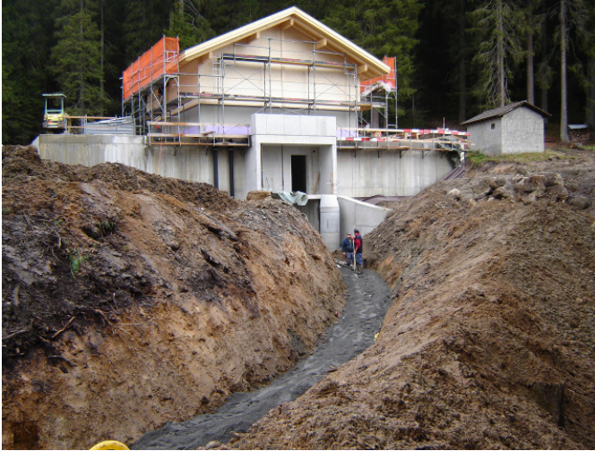
Nach der Fertigstellung Rohbau Grabarbeiten Abgangsleitung
