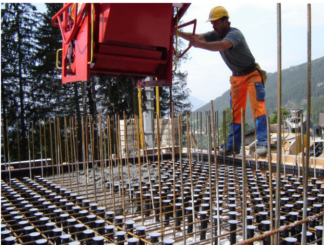
Schalungseinlagen für Filteranlage
