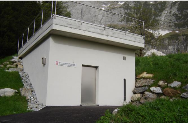
Neues Entkeimungsgebäude nach der Fertigstellung
