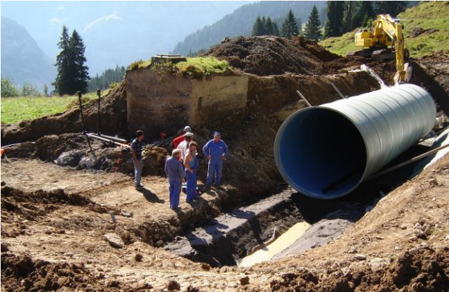
Der erste Teil des vorfabrizierten Behälters
