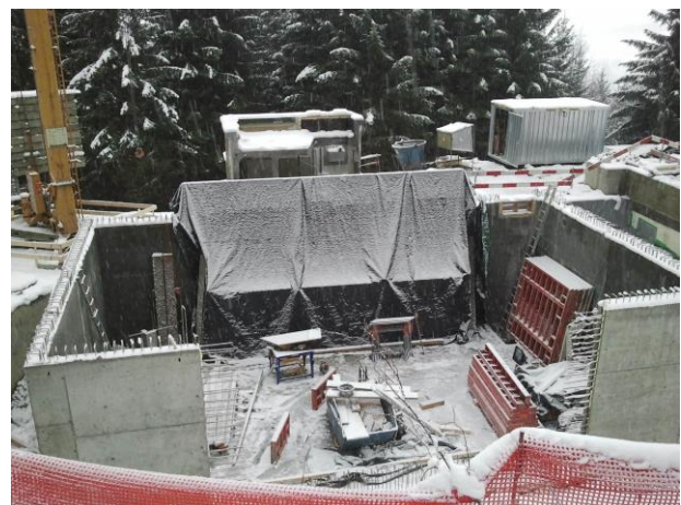
Neuer Behälter im Bau
