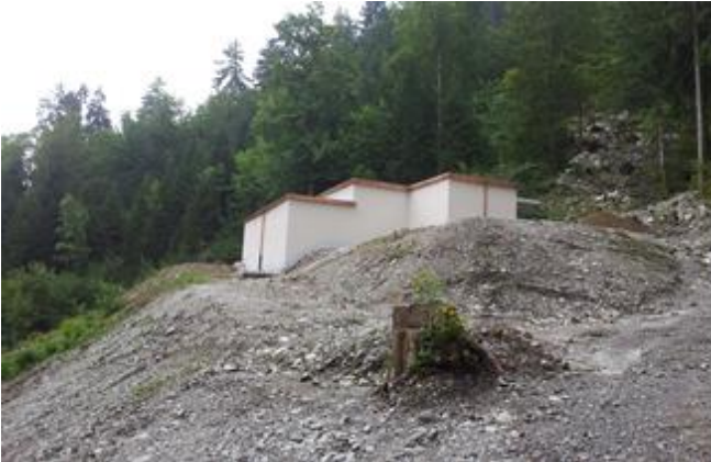
Nach der Fertigstellung
