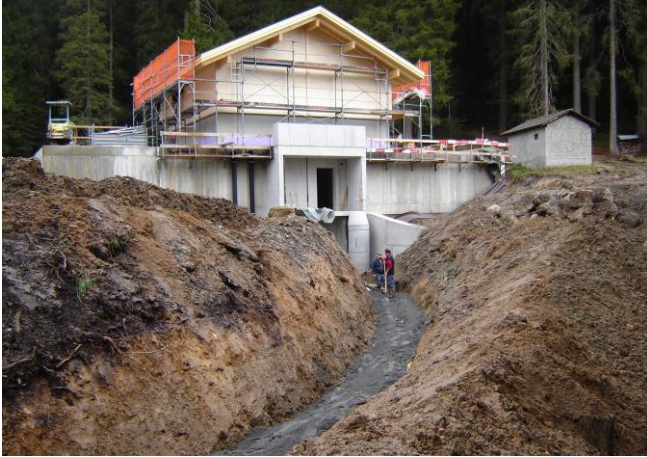
Nach der Fertigstellung Rohbau Grabarbeiten Abgangsleitung
