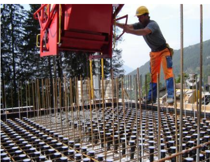
Schalungseinlagen für Filteranlage
